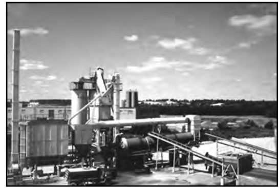
Photo 3-2 : Poste d'enrobage type à fournée et à four tournant, à écoulement à contre-courant.
