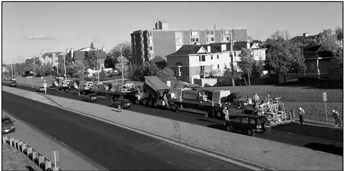
Photo 3-3 : Chaîne actuelle de recyclage en place par thermorégénération en train de réhabiliter une chaussée municipale en une seule passe (2002).
