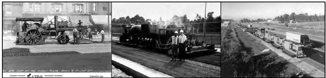
Photo A-9 : Recyclage à chaud et l'équipement utilisé dans le passé et le présent.
