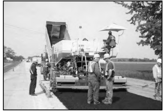
b) Livraison sur les lieux pour ensuite être posé à l'aide d'une finisseuse Midland.
