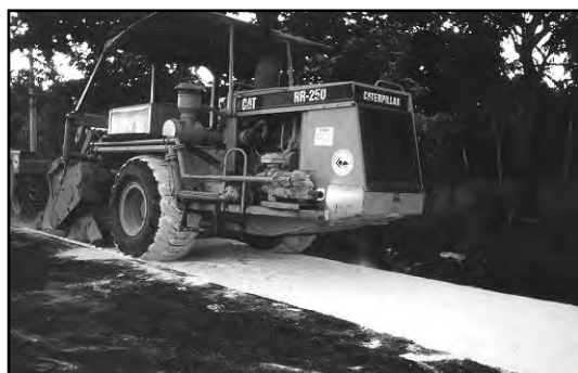
Photo 3-8 : Valorisation intégrale avec stabilisation à la chaux.
