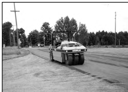
d) Compactage initial avec rouleau à pneus lourd suivi d'un rouleau vibreur en acier.
