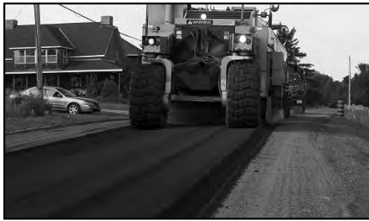
Photo 3-6 : Appareil classique de stabilisation intégrale au bitume moussé.
