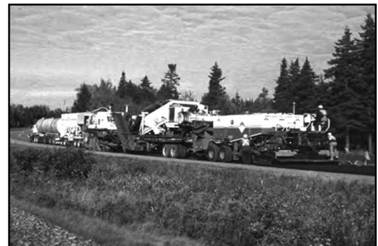
Photo 3-5 : Projet RFP avec ajout de laitier de ciment, exécuté en Ontario en 1999.
