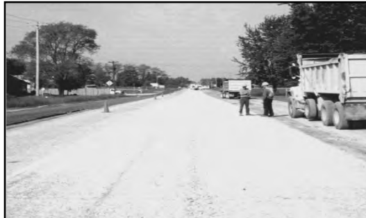
d) Aspect après compactage de la route 2 du comté d'Oxford.
