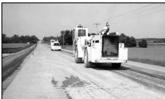
a) Pulvérisation du BCP à l'aide de trois concasseurs à résonance IRB se déplaçant en formation échelonnée
