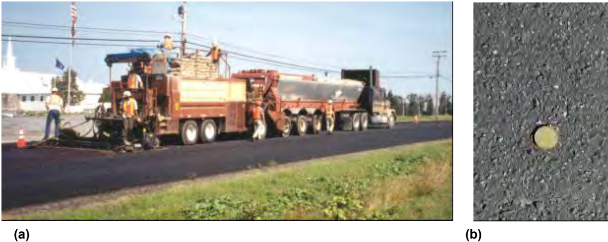
Figure 3-7 : Mélangeur de microrevêtement à alimentation en continu autopropulsé sur camion (a); texture superficielle (b).
