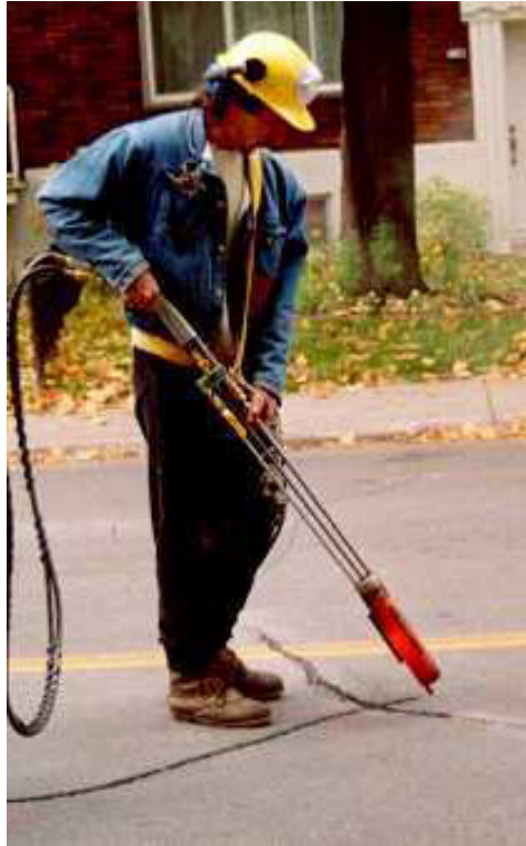
Photographie 3–3 : Une lance thermopneumatique.
