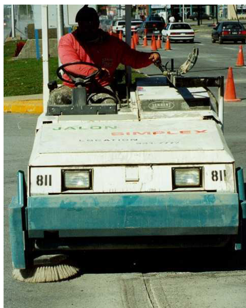
Photographie 3-2 : Un balai mécanique sert à dégager la poussière et le fraisat.
