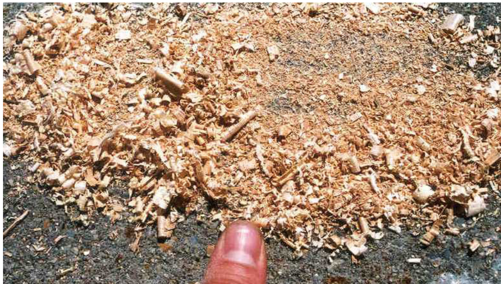
Photographie 3-4 : On se sert de copeaux de bois fins pour protéger la surface chaude des thermomastics.
