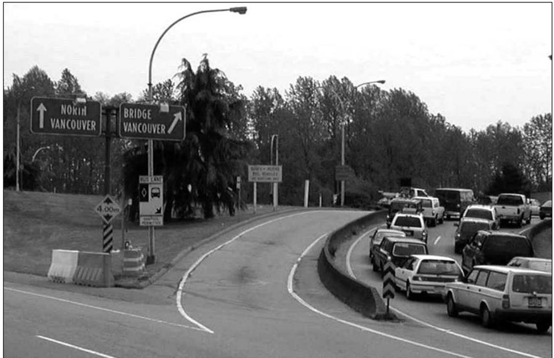
**Figure 3-7 :** Voie d'évitement de file d'attente à l'approche du pont.
