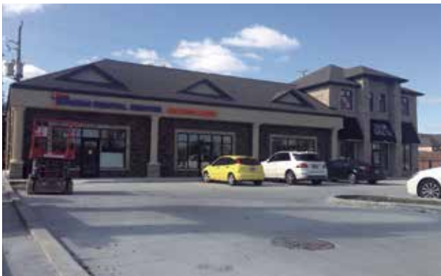
3001, av. Dougall pendant la construction
